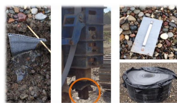
Slika 5. PVD u tlu, b) Mandrela, c) Sidrena pločica, d) Rola PVD-a
